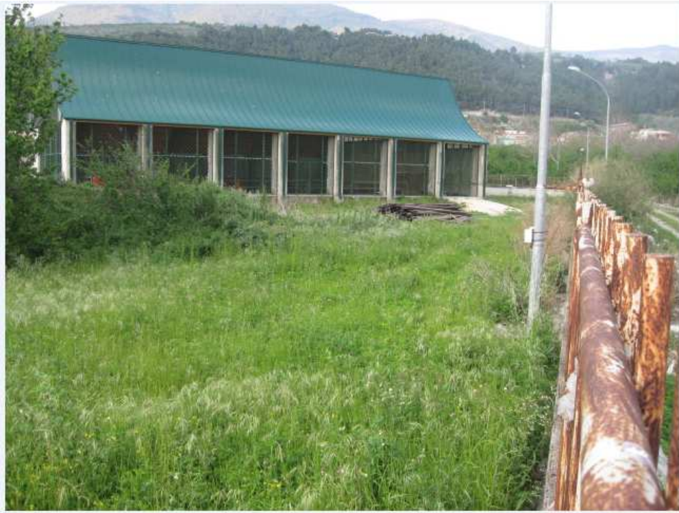
Il locale vasca con la copertura realizzata di recente
