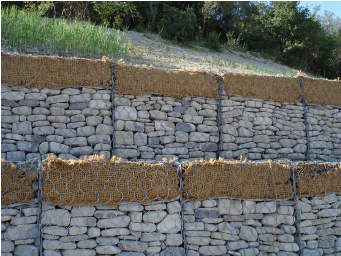
Fig.5: Gabbioni con tasche vegetative per rinverdimento
