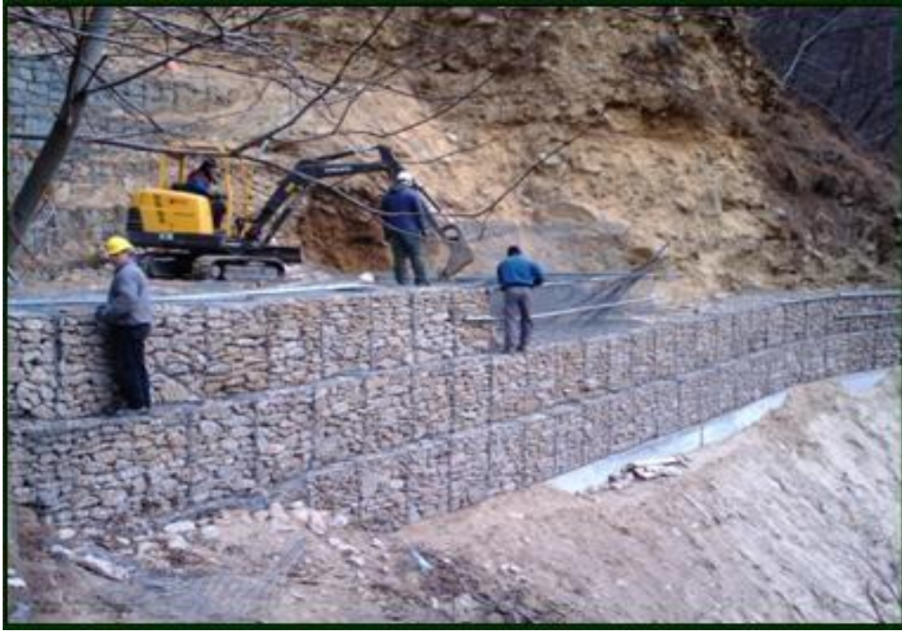
Fig.4: Particolare della posa in opera di Gabbioni in pietrame
