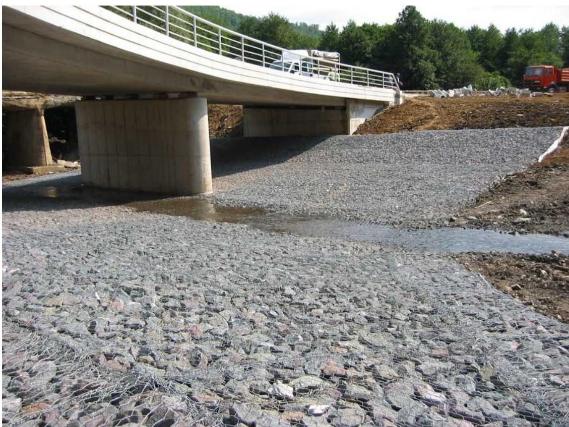
Fig.6: Sistemazione del fondo alveo con Materassi tipo Reno
