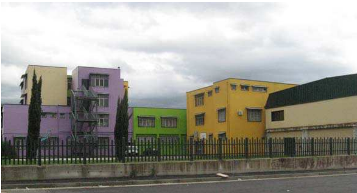
Figura 4 - Fotografia dell'edificio visto da sud-est
